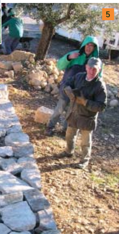
Arase du mur
